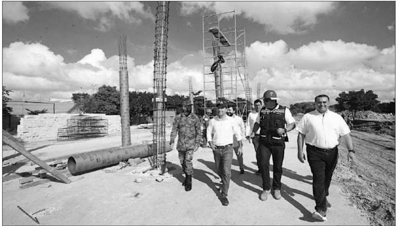
▲ Junto con el alcalde de Mérida, Renán Barrera Concha, Vila Dosal se trasladó a la zona donde se está levantando el Mercado Gastronómico y el Museo, para después concluir su trayecto en la construcción del lago artificial. Foto gobierno de Yucatán
