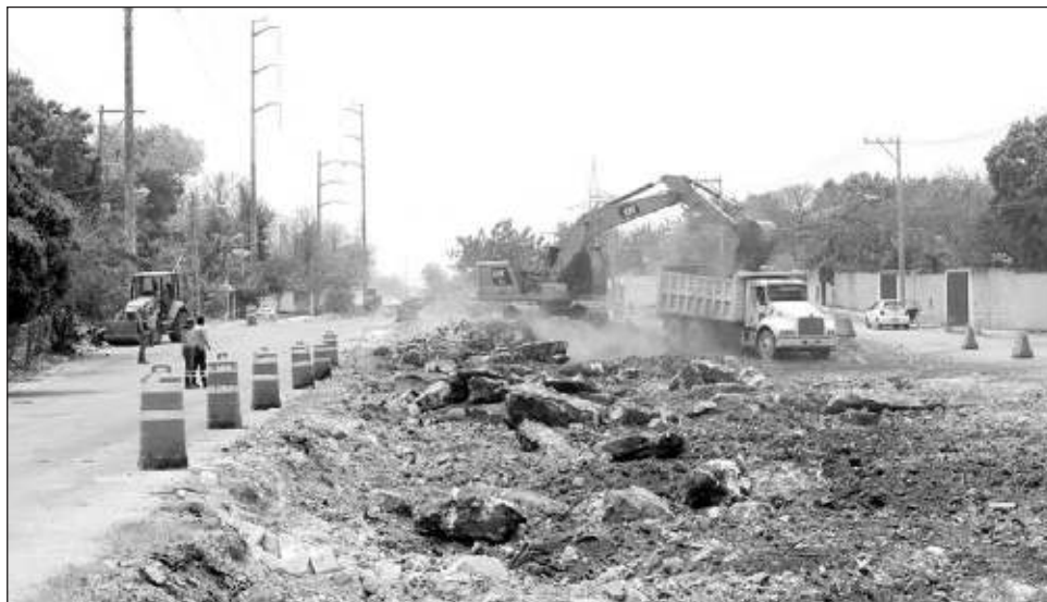
▲ El gobernador recorrió las obras que consisten en el mejoramiento de la infraestructura vial, civil y eléctrica en 10 kilómetros que van del Gran Parque La Plancha hasta la calle 108. Foto gobierno de Yucatán
