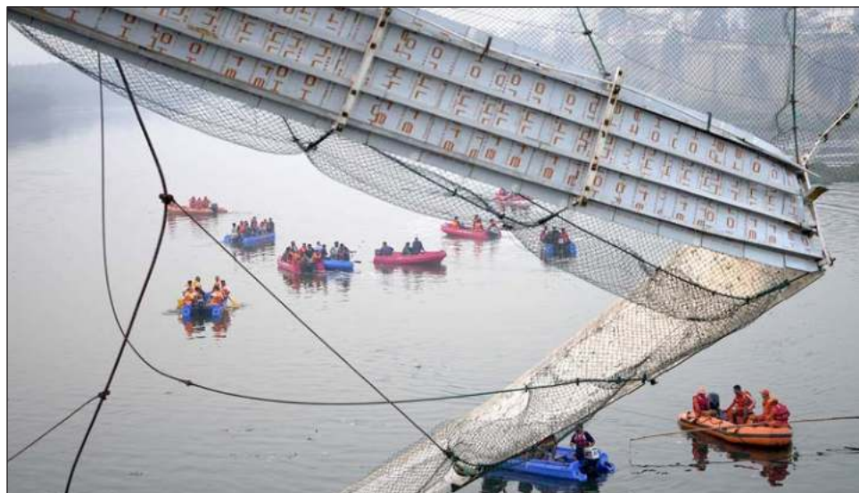
▲ El puente sobre el río Machchu fue construido hace 143 años. El pasado mes de marzo, el poblado de Morbi contrató por 15 años al consorcio Oreva para dar mantenimiento a la estructura. Foto Ap
