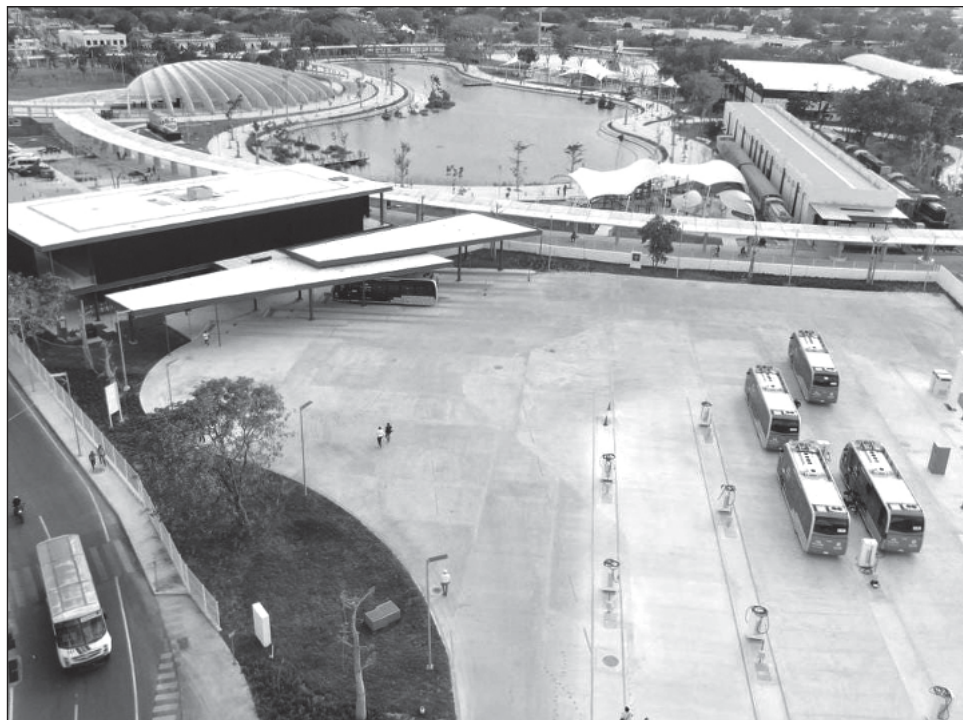
▲ Las instalaciones fueron dotadas de aire acondicionado, iluminación de led y de huellas podotáctil de cerámica en piso; muros cargadores, muebles sanitarios, así como la instalación de un sistema de circuito cerrado de televisión con cámaras de seguridad. Foto gobierno de Yucatán
