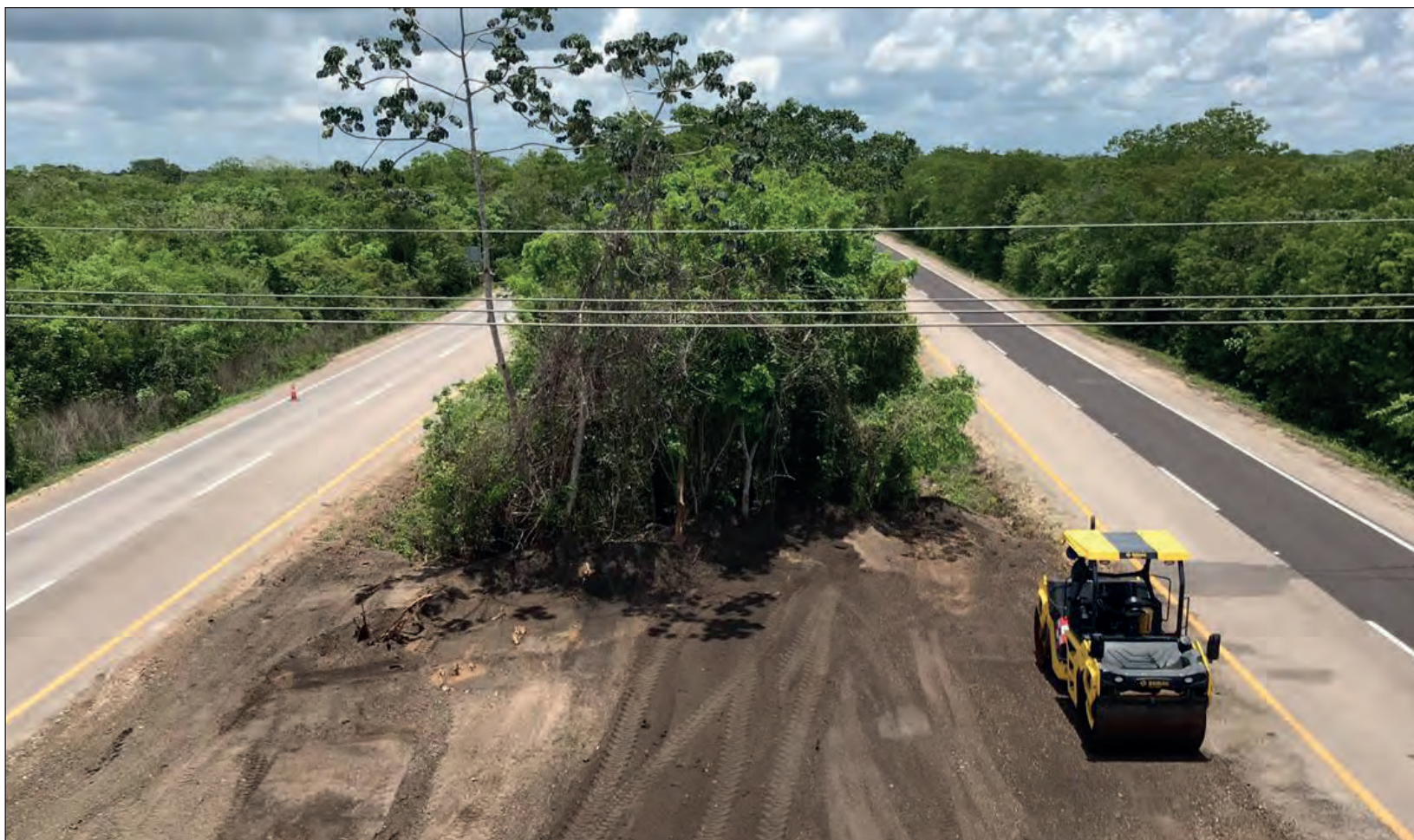
▲ El proceso de ampliación contempla el desmonte o retiro del material vegetal, el despalme y la excavación. Foto Fonatur
