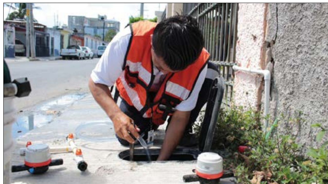
▲ Un supervisor de la brigada revisará el medidor, línea externa, tinaco o cisterna en busca de posibles fugas. Foto Aguakan
