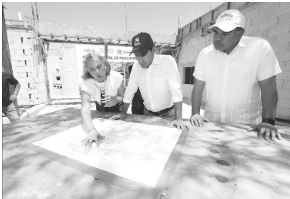
▲ El alcalde Renán Barrera Concha aseguró que “la construcción del hospital veterinario es otro gran paso que consolida a Mérida como una ciudad incluyente, sustentable y humana, que trabaja por el bienestar y la protección de los animales”. Foto gobierno de Yucatán
