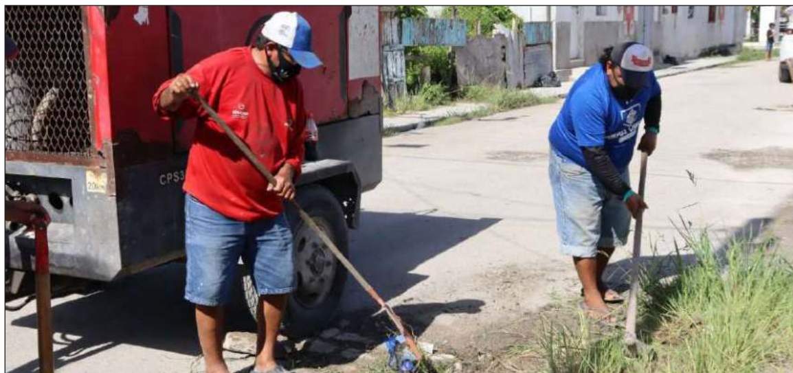
▲ El municipio dio a conocer que en distintas zonas del puerto habrá repavimentación de calles, por lo que esperan cortes en el flujo vehicular local. Foto ayuntamiento de Progreso
