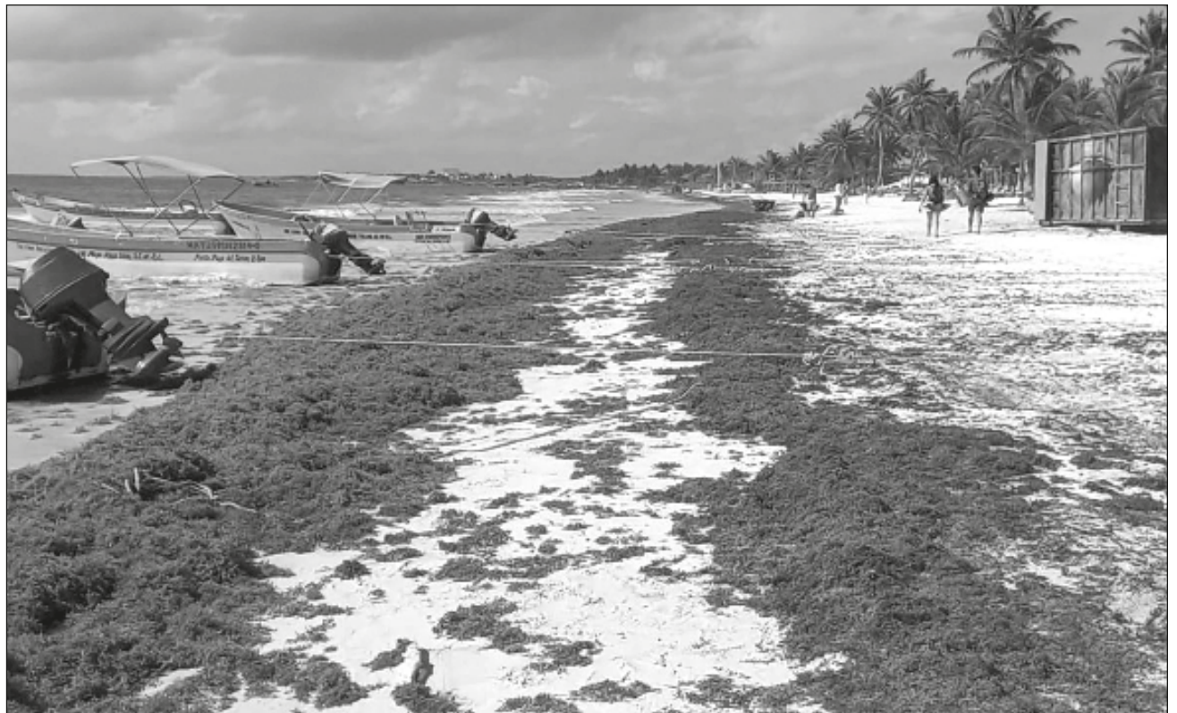
▲ A inicios de esta semana comenzó la colocación de boyas en altamar y descarga en tierra firme de los primeros tramos de la infraestructura que busca evitar el recalcado del sargazo en las costas del noveno municipio. Foto Miguel Améndola
