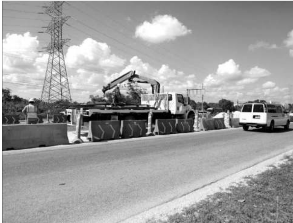
▲ Se realizarán diversas obras para mejorar la vía principal de acceso a Playa del Carmen. Foto Ayuntamiento de Solidaridad
