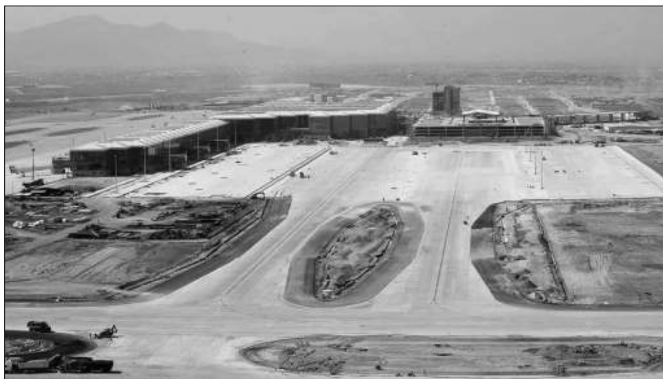
▲ El Grupo Aeroportuario, Ferroviario de Servicios Auxiliares y Conexos Olmeca-Maya-Mexica se enfila a tener los aeropuertos de Nogales, Nuevo Laredo, Ciudad Victoria, Tamián, Uruapan, Puebla, Ciudad Ixtepec, Palenque, Chetumal, Campeche y Tulum. Foto María Luisa Severiano
