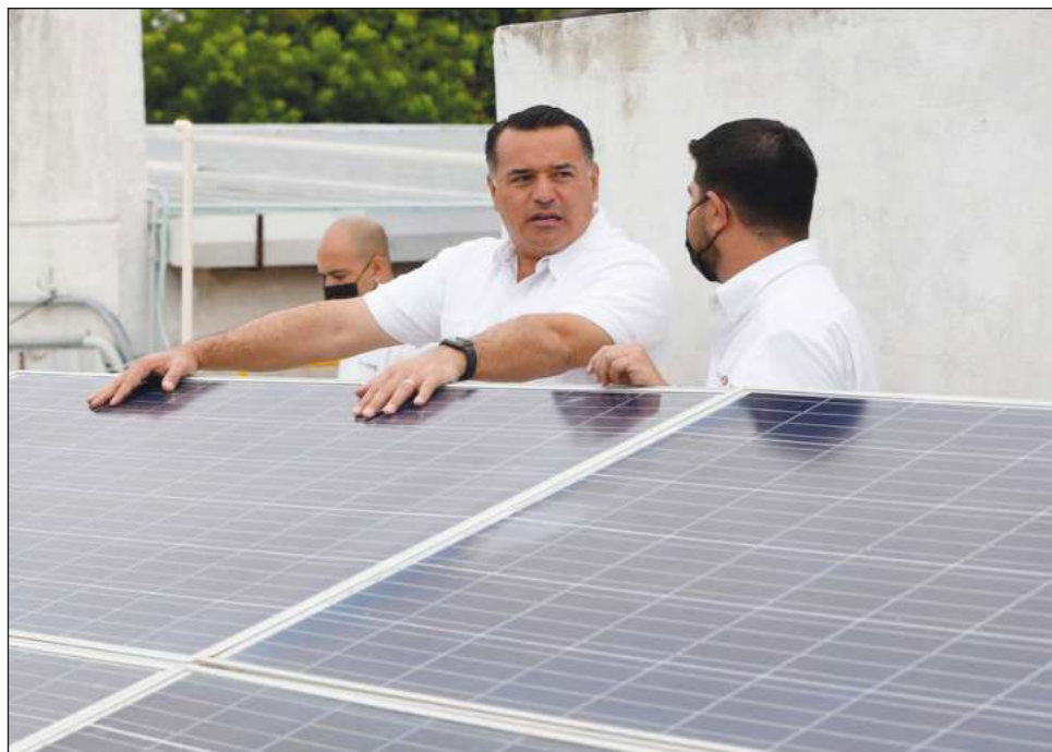
▲ Mérida es una de las ciudades firmantes para ser neto cero en 2050, por lo que debe realizar procesos que lleven a la descarbonización. Foto ayuntamiento de Mérida
