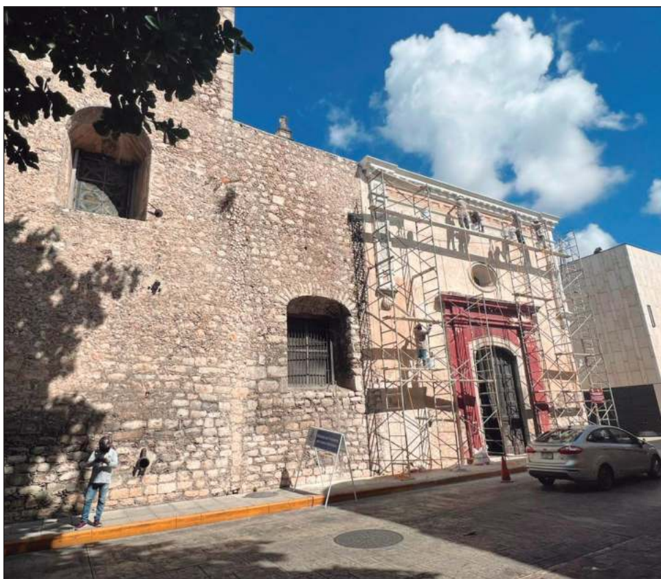
▲ Las acciones consisten en retiro de vegetación parásita, limpieza de muros, consolidación de la mampostería expuesta y colocación de aplanados de cal en el muro sur. Foto INAH
