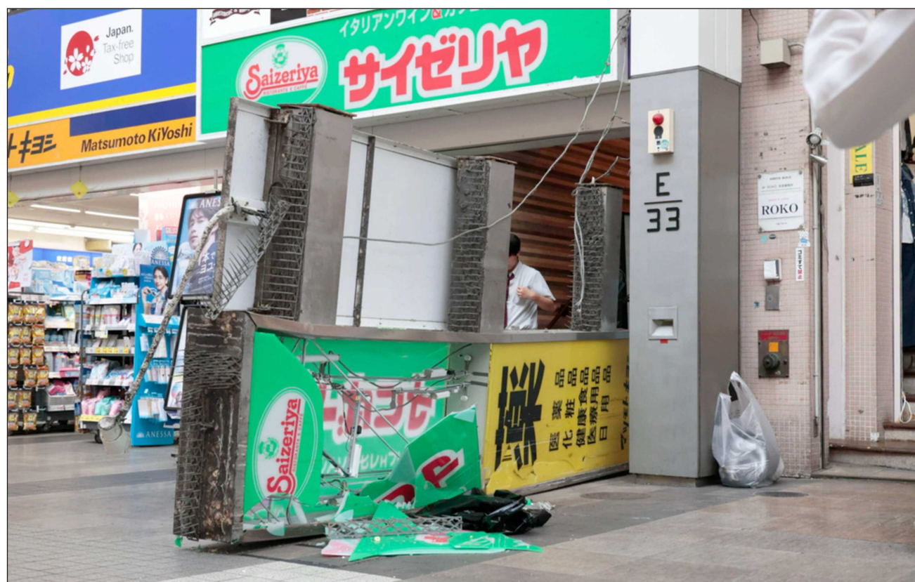
▲ La primera ministra Sanae Takaichi informó que había reportes de daños en carreteras, puentes y edificios, así como apagones e incendios, aunque los detalles aún no están claros; no había registro de daños en las principales instalaciones públicas. Foto Ap
