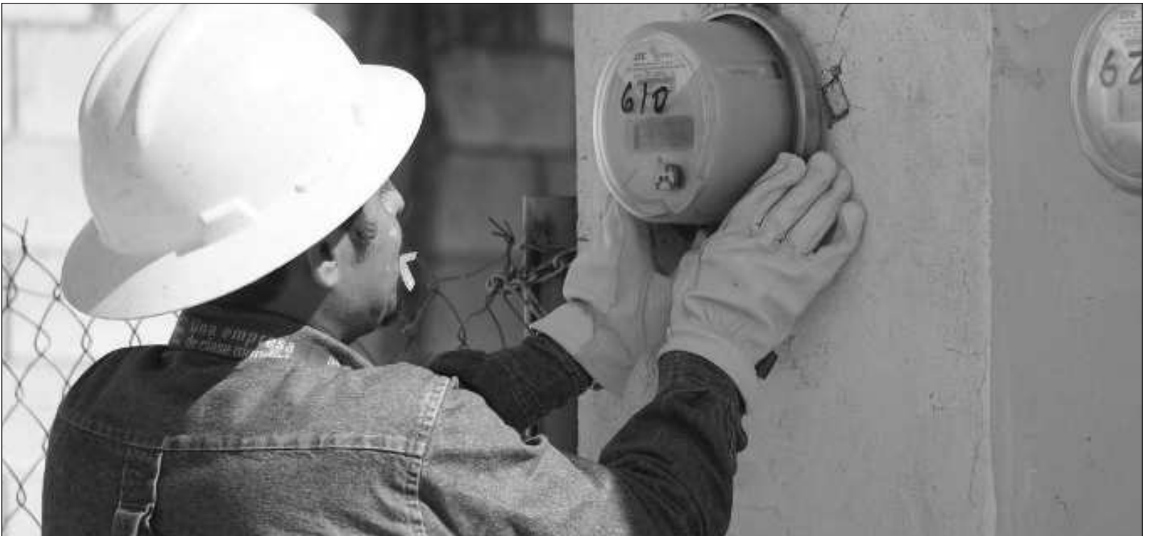
▲ Gobierno del estado de Campeche y la Comisión Federal de Electricidad presentaron avances de la obra para la subestación en la zona. Foto Fernando Eloy
