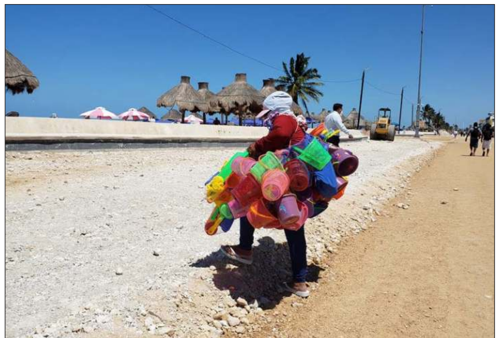
▲ Continúan las obras de remodelación en el último tramo del malecón de Progreso. Sin embargo, a menos de dos semanas de la Semana Santa, el ayuntamiento no
