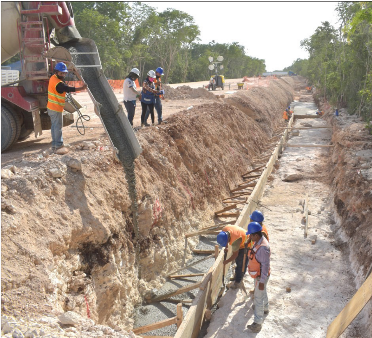
▲ Durante la realización de los trabajos se tratará de afectar lo menos posible la circulación sobre la carretera federal. Foto Fonatur
