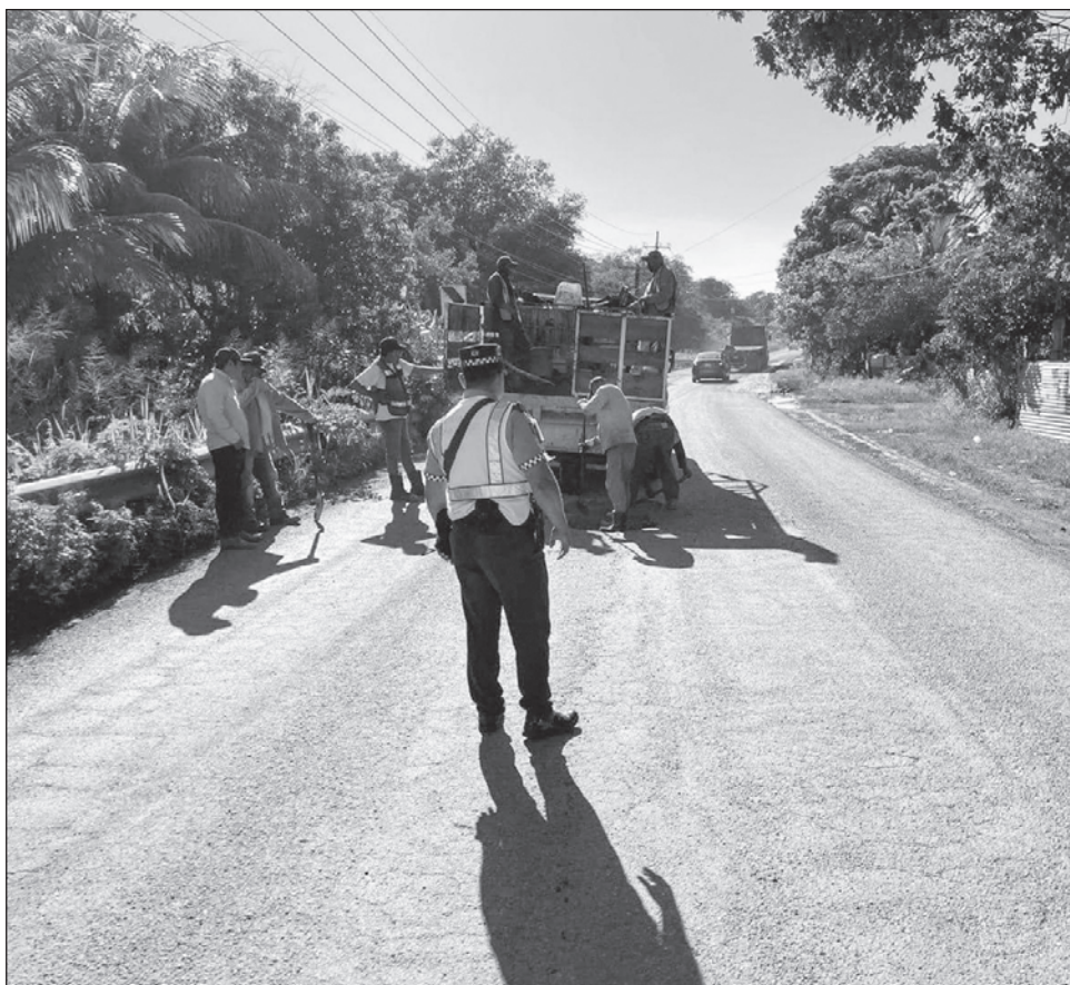
▲ Hasta el momento se desconoce el tiempo estimado de la obra de rehabilitación de los 12 kilómetros que contempla esta importante carretera. Foto Facebook Dalila Mata
