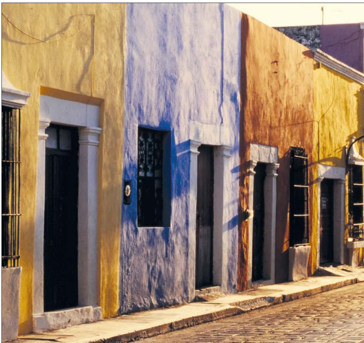
▲ El proyecto contempla el remozamiento de fachadas e intervención del Patrimonio Cultural Edificado. Foto jusaeri
