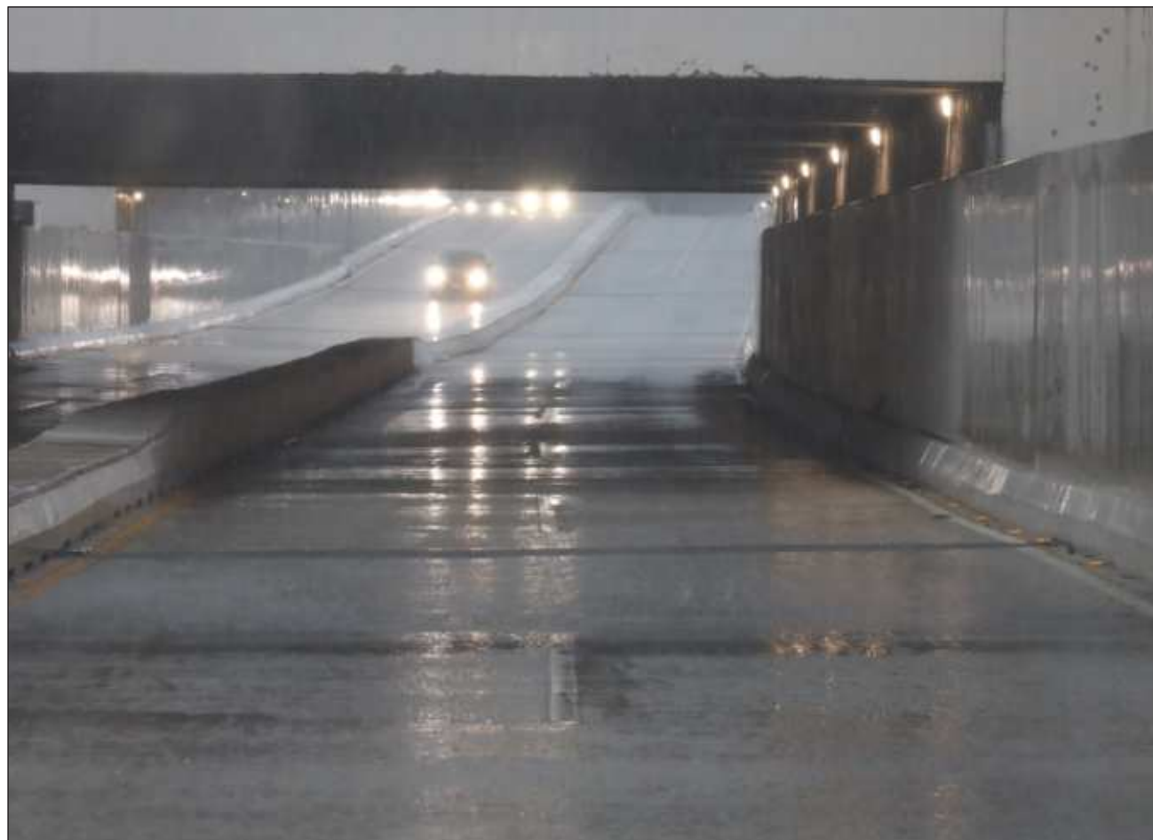
▲ Pese a las fuertes lluvias registradas la tarde del lunes, el Paso Deprimido de Mérida no sufrió el mismo destino que muchas calles de la ciudad y se mantuvo libre de inundaciones. Esta vialidad a desnivel fue rehabilitada tras quedar prácticamente sumergida después del paso de la tormenta tropical Cristóbal por la entidad, en 2020. Foto Gerardo Jaso
