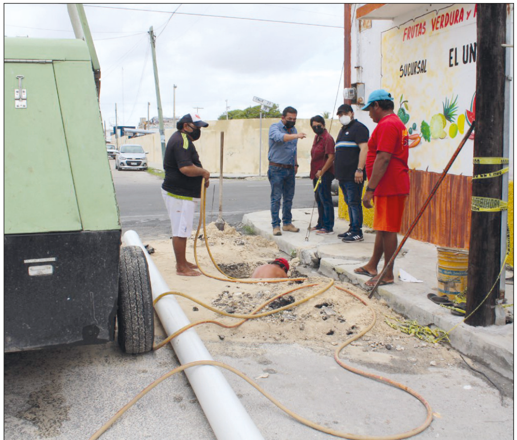
Esta semana se construirá otro pozo sobre la calle 29 para reforzar el sistema pluvial. Foto ayuntamiento de Progreso
