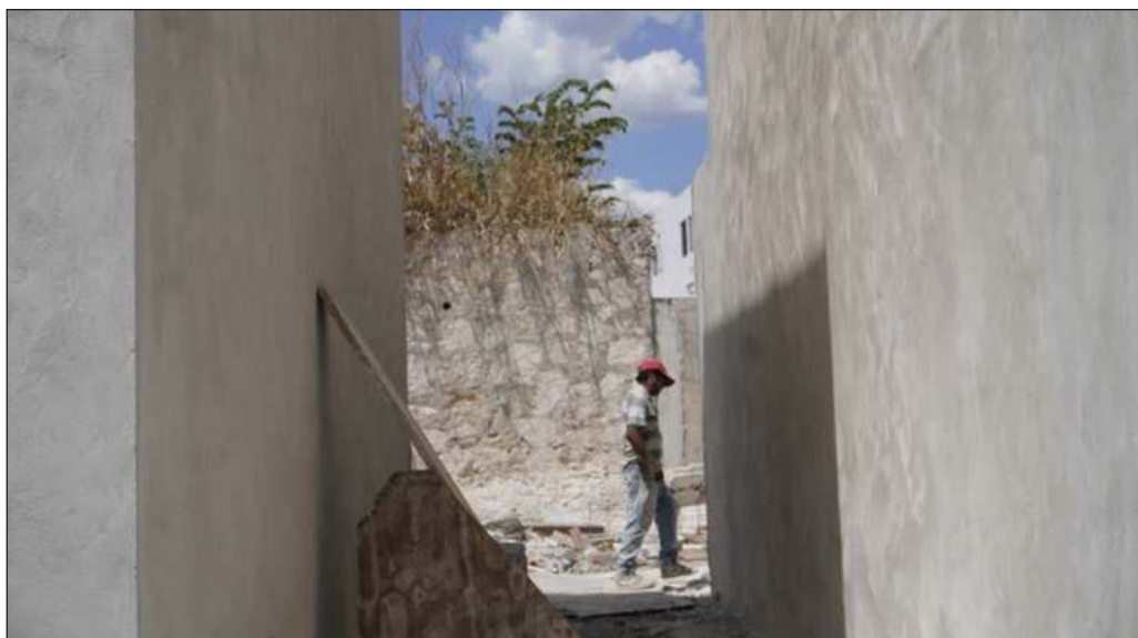
▲ La promesa de un puesto como auxiliar en la construcción en Q. Roo es de sobra conocida como para que genere desconfianza. Sin embargo, el mercado turístico ha terminado por generar sus demonios. Foto Fernando Eloy
