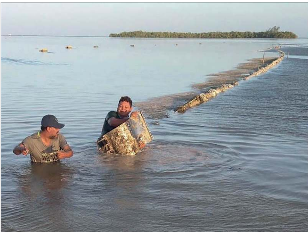
▲ Trabajadores de la Comisión de Agua Potable y Alcantarillado trabajan en la reparación de los ductos que suministran del vital líquido a la isla. Foto Gobierno de Q. Roo
