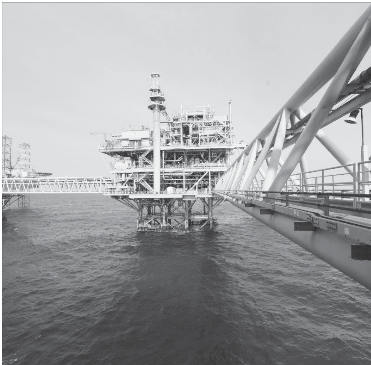
▲ Las fuentes consultadas coincidieron que en esta ocasión no se presentaron lesionados ni daños a las instalaciones, ya que de inmediato pusieron en marcha las medidas de contención y emergencia necesarias. Foto Pemex
