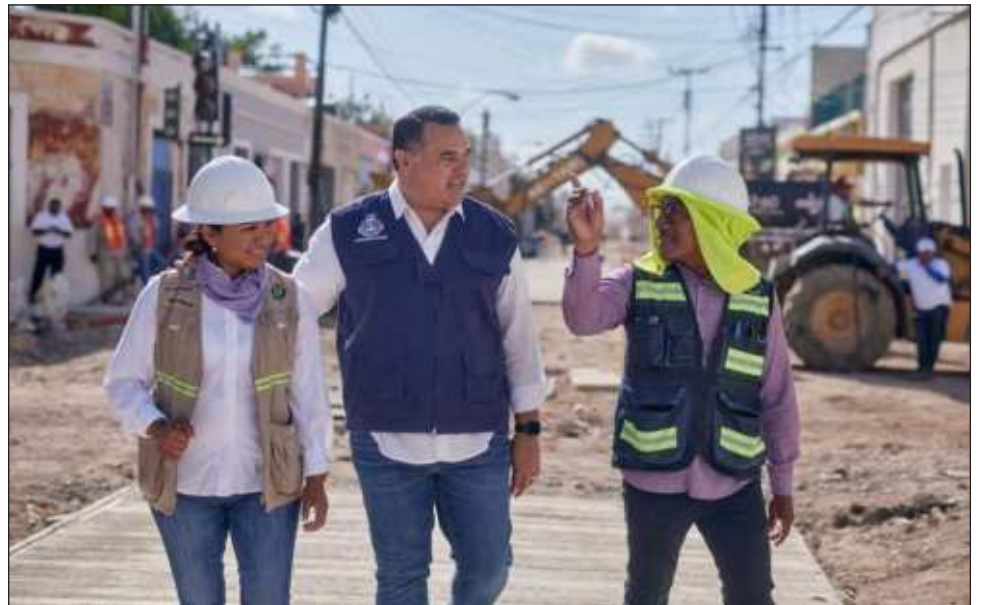
▲ El alcalde Renán Barrera explicó que ya se inició la instalación de los sistemas pluviales del Corredor Turístico Gastronómico de la calle 47, en donde personal de Obras Públicas coloca los canalones que servirán como sistema de drenaje pluvial. Foto ayuntamiento de Mérida
