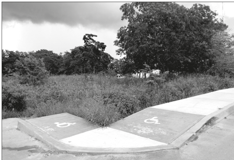
▲ Las infraestructuras como rampas para discapacidad motriz carecen de espacios suficientes, sin contar los obstáculos que suele haber en el camino, tanto en éstas como en las aceras mismas, que son estrechas. Foto Juan Manuel Valdivia
