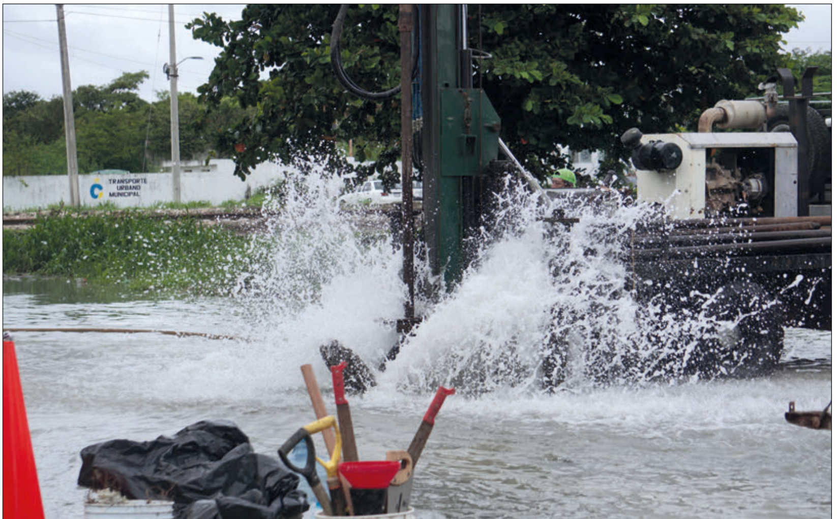
▲ Si el servicio de agua potable debió interrumpirse tres días para realizar los trabajos de mantenimiento. Foto Fernando Eloy
