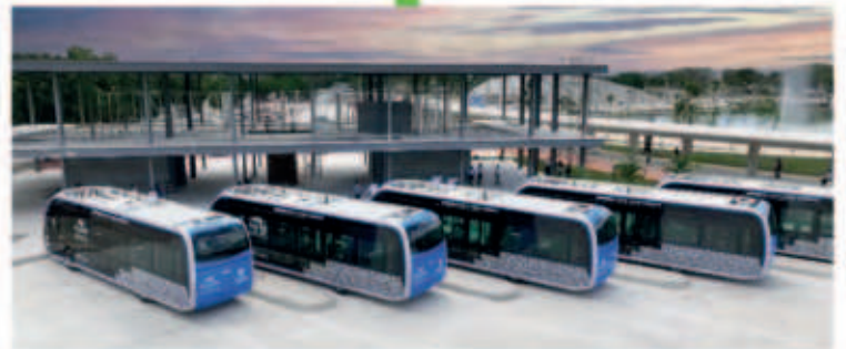
Se construye la estación del IETRAM en el Parque la Plancha, para 3 rutas de este transporte público 100% eléctrico y único en su tipo en Latinoamérica.
