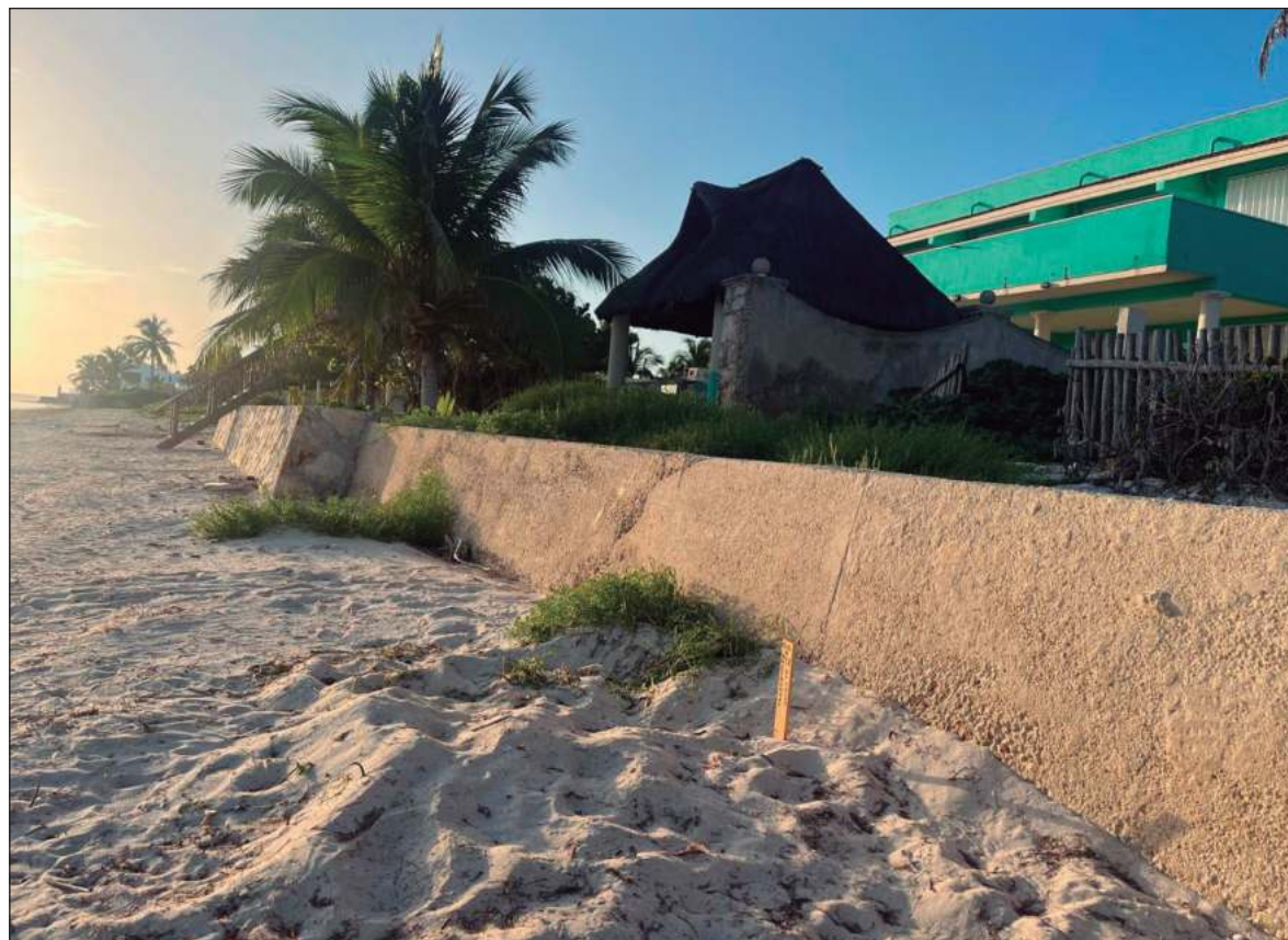
▲ “En los últimos tres años en las playas de Chelem, Chicxulub y Telchac, se han visto tortugas intentado desovar sin éxito por falta de playas o llenas de escombros y muros de piedra en plena zona federal marítima”. Foto Dalila Aldana
