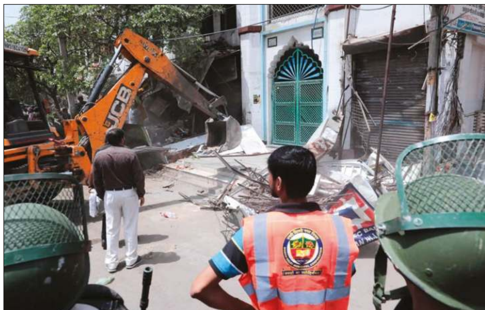
▲ Los habitantes de Jahangirpuri denunciaron que las demoliciones sólo se llevaron a cabo en torno a la mezquita de la comunidad, la zona donde viven los musulmanes. Foto Efe
