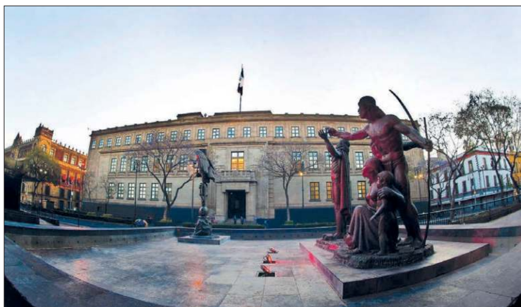
▲ El PJF inaugurará una nueva era, en la cual la Cuarta Transformación ha cifrado muchas esperanzas. Foto SCJN
