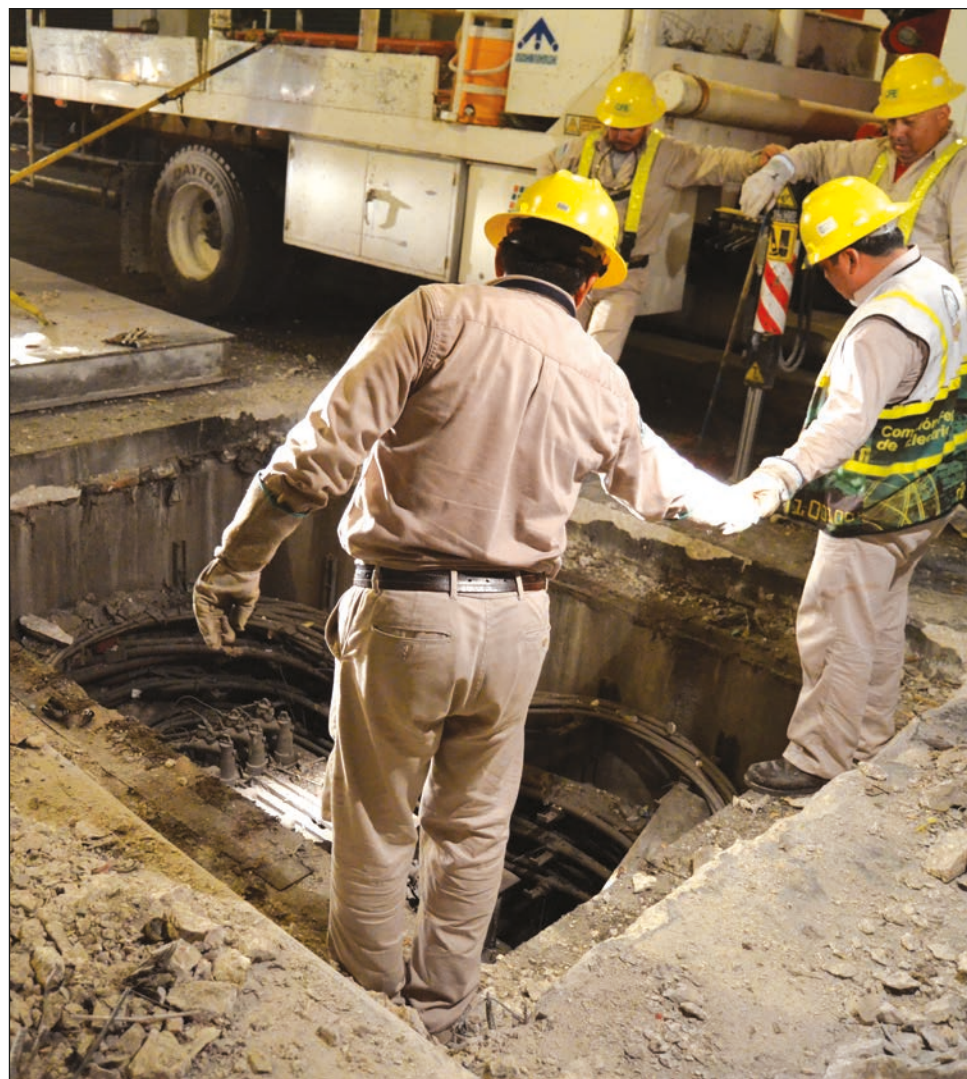
▲ En las colonias Puntilla y Renovación II Sección se cambiaron líneas de conducción de baja y media tensión. Foto Rodrigo Díaz Guzmán
