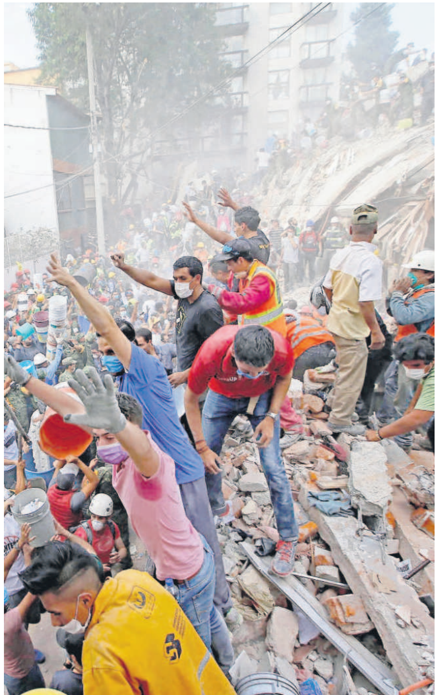
▲ Edificio de departamentos colapsado en Gabriel Mancera y Escocia, Ciudad de México, 19 de septiembre de 2017. Foto: La Jornada/ Marco Peláez.
