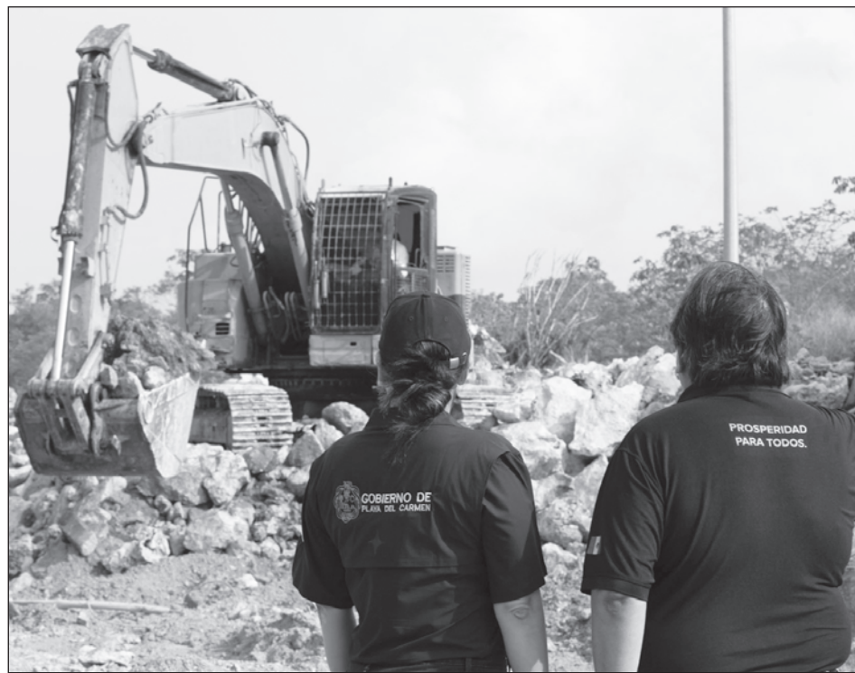
▲ La alcaldesa Estefanía Mercado supervisó el arranque de la pavimentación de la avenida Constituyentes, en el tramo Avenida Loros y Playa Paraíso. Foto ayuntamiento Playa del Carmen
