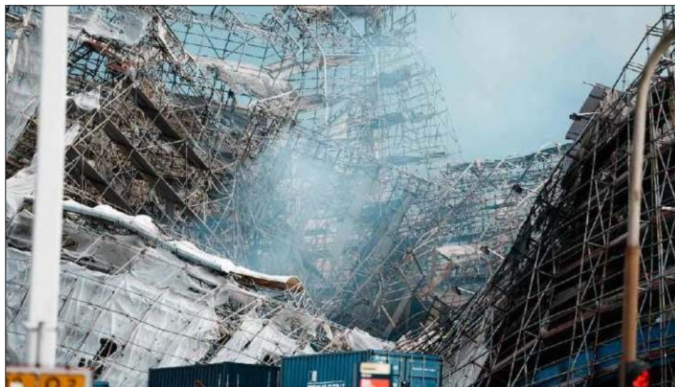
▲ "Teníamos muchas esperanzas de poder salvar las fachadas de este antiguo edificio, pero lamentablemente no tuvimos tiempo de instalar los anclajes", explicó Jakob Vedsted Andersen, otro responsable de los servicios de rescate. Foto Afp
