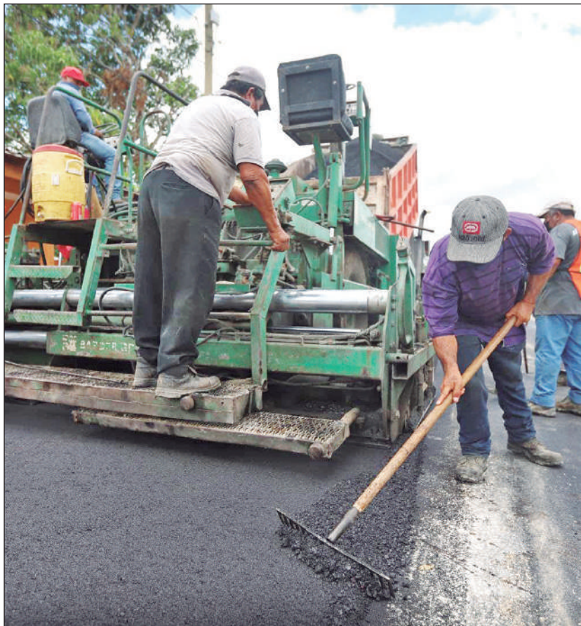
▲ La obra consta de 13 mil metros cuadrados de pavimentación, y permitirá cerrar circuitos viales para mejorar la movilidad urbana. Foto ayuntamiento de Puerto Morelos
