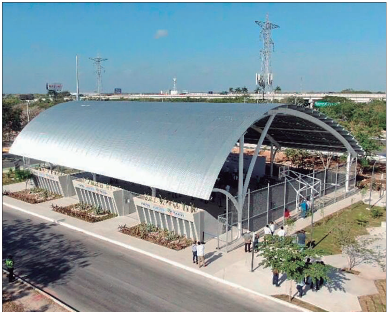
▲ La cancha cuenta con gradas con un espacio para 100 personas. Foto gobierno de Yucatán
