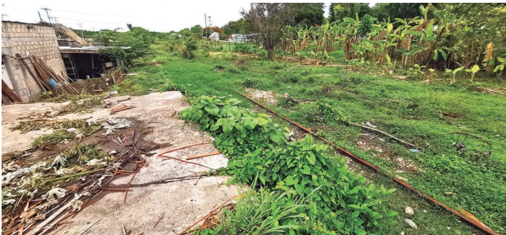
• Plataforma de descarga y mantenimiento a ruedas de locomotoras en Miguel Alemán
