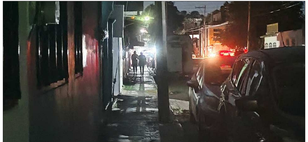
▲ La causa que lleva a que este problema se incremente en esta temporada de calor es que no existe la planeación de mantenimiento preventivo a las líneas de conducción y a los transformadores. Foto Fernando Eloy / Archivo
