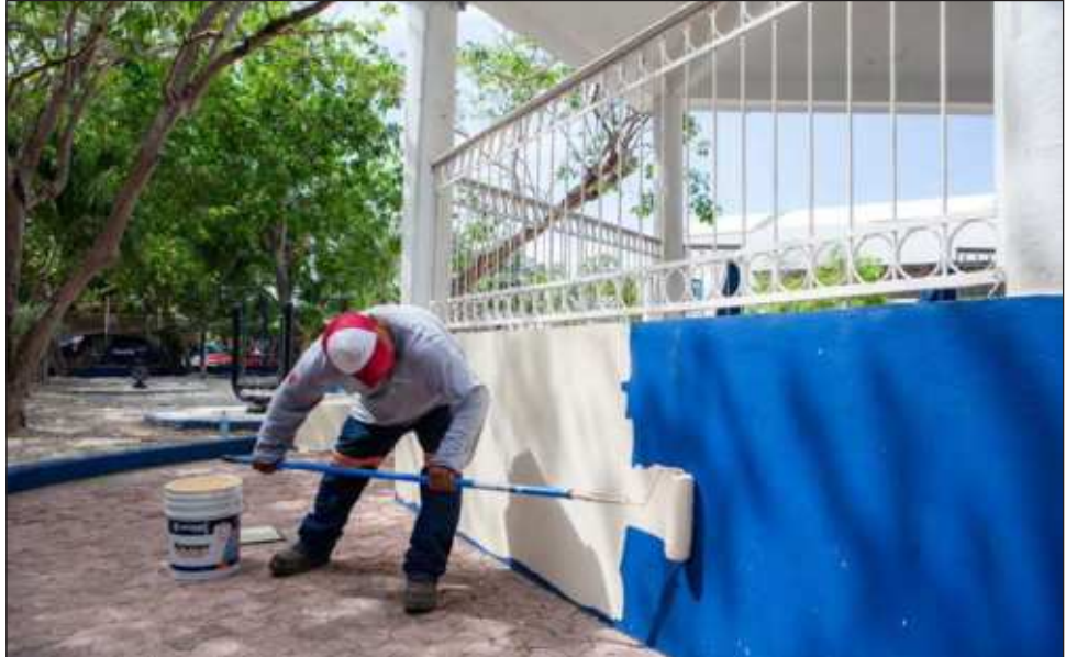
▲ Las acciones incluyen limpieza general, pintura, rehabilitación de áreas ajardinadas, retiro de juegos dañados y residuos, así como poda estratégica de árboles. Foto ayuntamiento de Playa del Carmen
