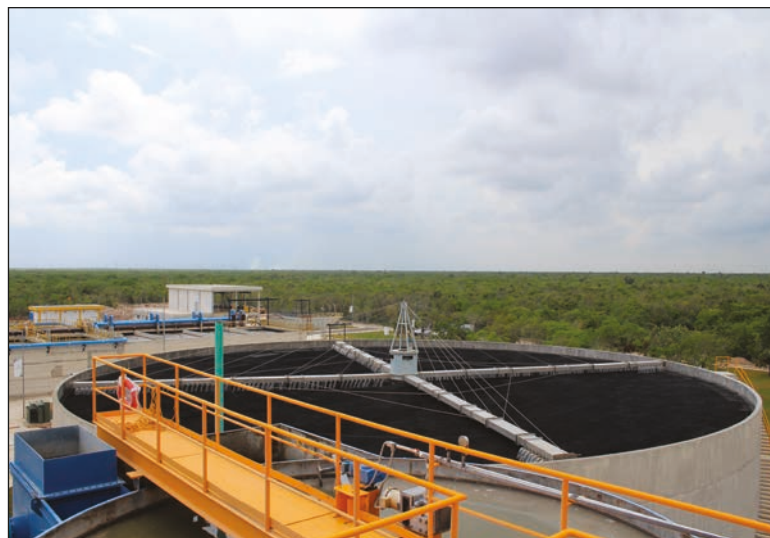
▲ La planta puede tratar hasta 200 litros por segundo. Foto Aguakan
