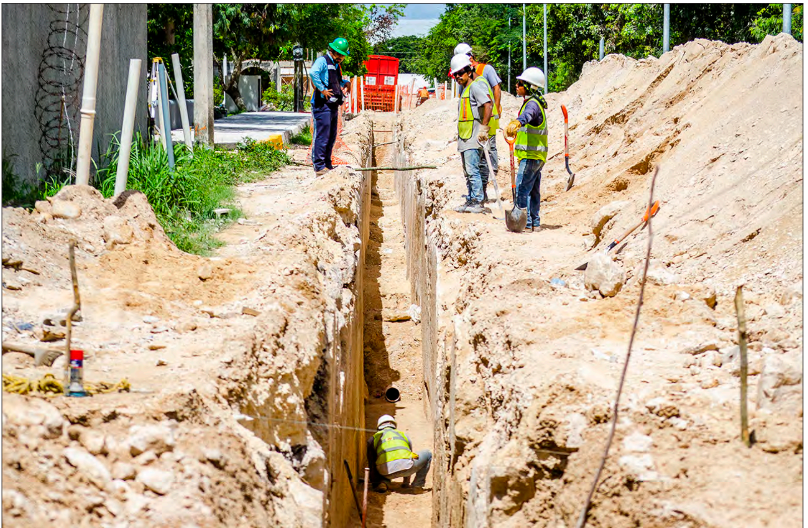
▲ La inversión en infraestructura para aumentar la cobertura del servicio de alcantarillado permitirá una recolección más eficiente de las aguas residuales. Foto Aguakan
