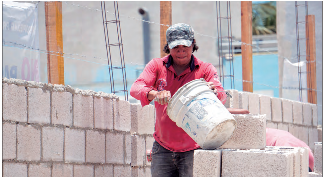
▲ Actualmente hay más de 500 obras ya iniciadas en todo el estado, con alrededor de 25 mil trabajadores. Foto Fernando Eloy
