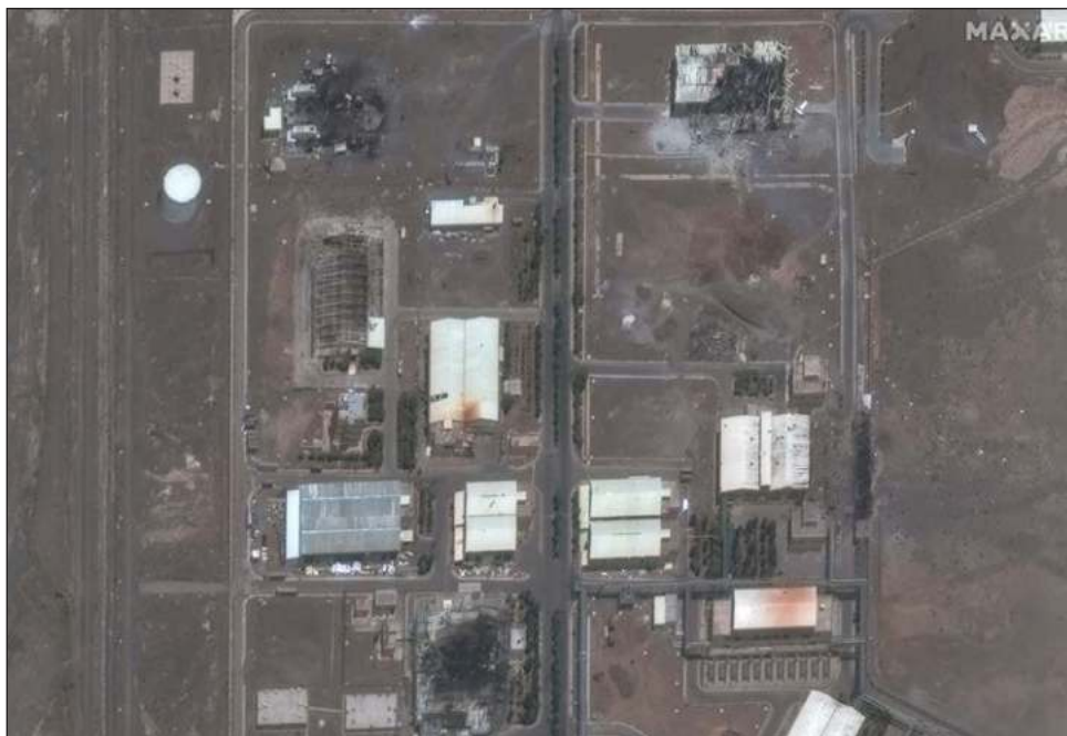
▲ Fotos satelitales muestran daños extensos en la principal instalación de enriquecimiento nuclear de Irán en Natanz tras los ataques israelíes, con múltiples edificios destruidos. Foto Ap
