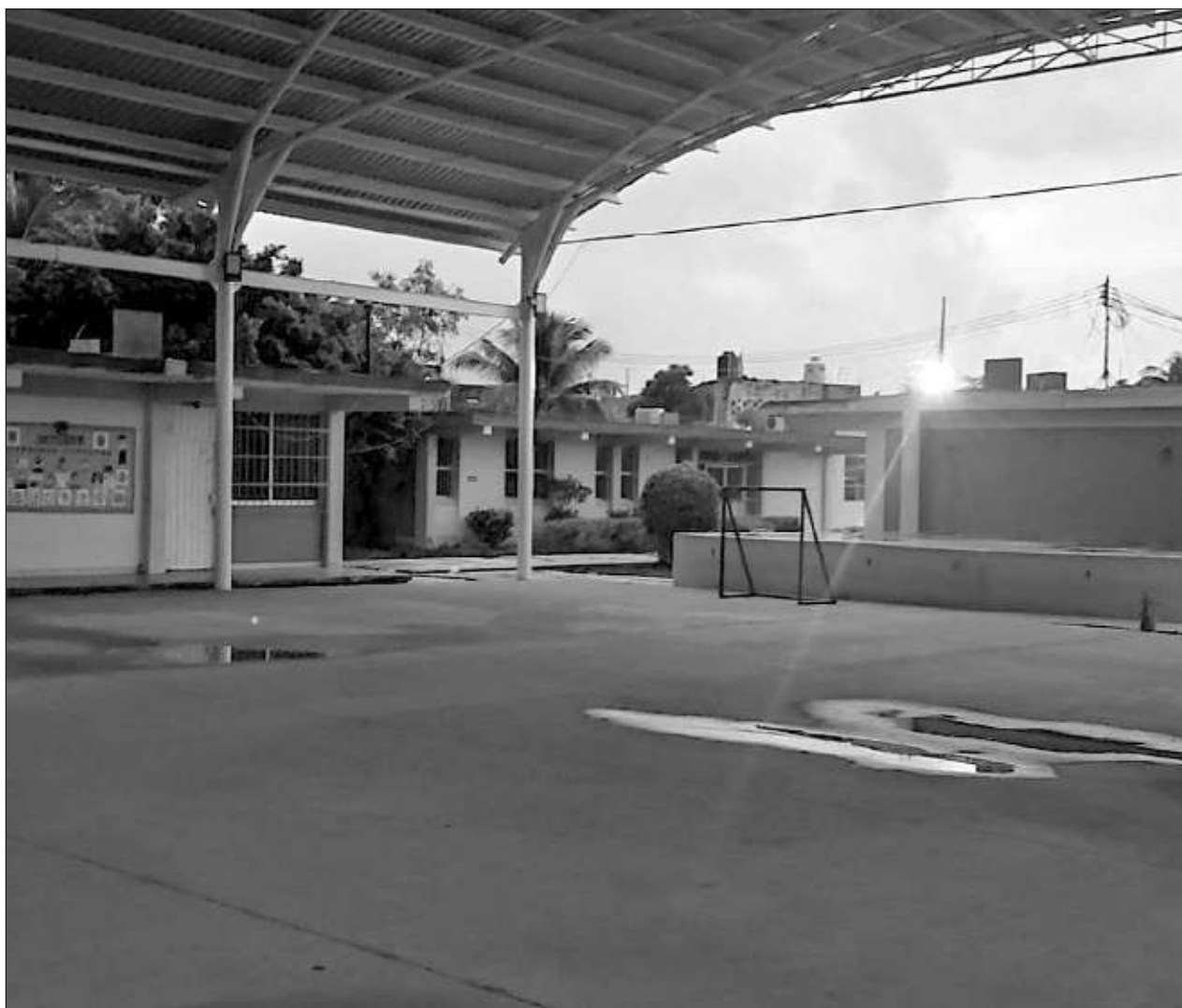
▲ El contratista a quien el Instituto de Infraestructura Física Educativa de Campeche contrató, no ha concluido los trabajos encomendados desde noviembre de 2022, cuando se averió el transformador que suministra de electricidad al plantel. Foto Facebook Liz Turquesa
