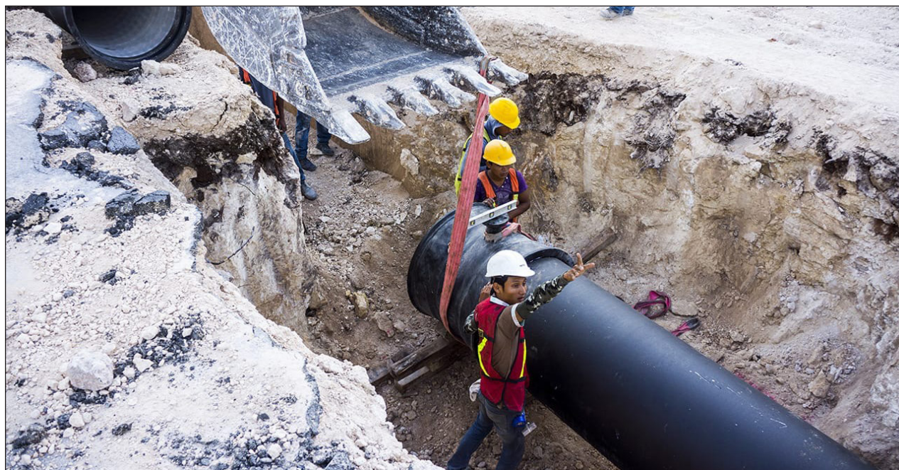
▲ Las dos obras de infraestructura dieron inicio este mes de febrero. Foto Aguakan
