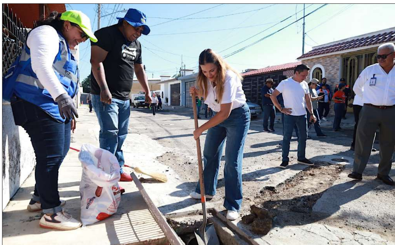
▲ Las labores contemplan limpieza de rejillas y desazolve de pozos, retiro de maleza y escombros, poda de árboles y bacheo de calles, con el objetivo de mejorar las condiciones de movilidad, higiene y funcionamiento. Foto ayuntamiento de Mérida
