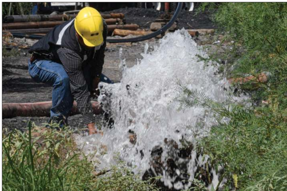
▲ Para el desagüe de El Pinabete se tienen 14 bombas con un total de 990 caballos de fuerza, aunque el ingreso aproximado de agua es de dos litros por segundo. Foto Afp
