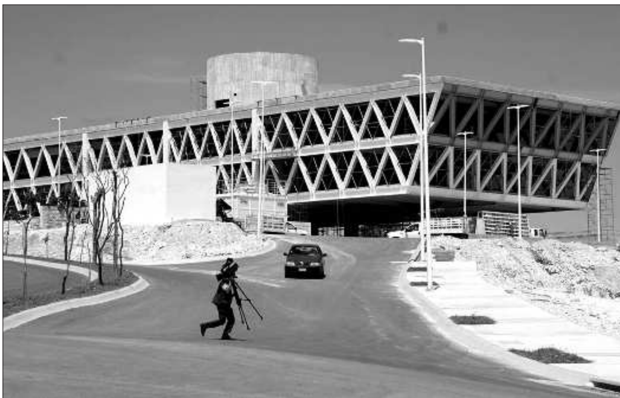
▲ Según lo observado por la Asecam, estos trabajos pese a que fueron pagados fueron ejecutados sin realizar una adecuada planeación, debido a que las obras no están concluidas, por eso no se encuentra operando y se reportan como suspendidas temporalmente. Foto Fernando Eloy
