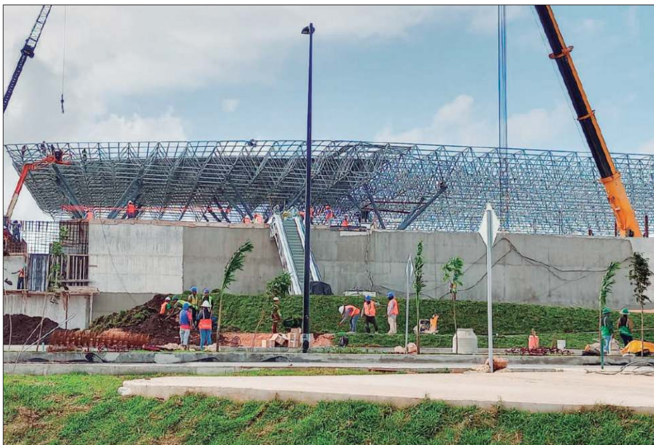
▲ En una visita por la estación Cancún Aeropuerto, la más importante del mega proyecto, se pudo notar un gran movimiento de trabajadores y maquinaria en actividad previo a la inauguración de la ruta Campeche-Cancún, que cubre los tramos 2, 3 y 4. Foto Ana Ramírez
