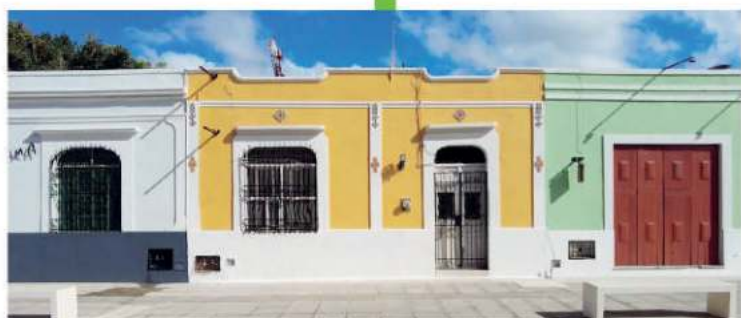
El Ayuntamiento de Mérida inviertió en la pintura en las fachadas de las viviendas que rodean al Parque de la Plancha.
