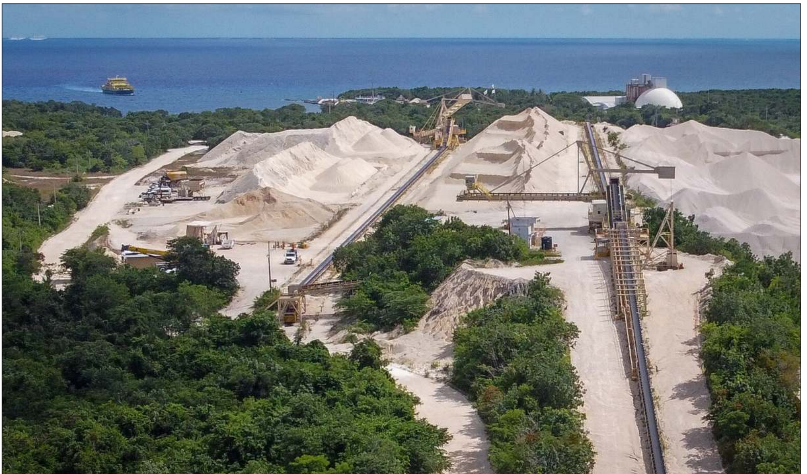
▲ De 2016 hasta abril de 2022 se observó que la extracción de material pétreo por debajo del nivel freático ha provocado el crecimiento de cuerpos de agua en los predios de Calica, impactando directamente los sistemas subterráneos acuáticos y al menos se destruyeron tres cenotes dentro del predio en cuestión. Foto Juan Manuel Valdivia
