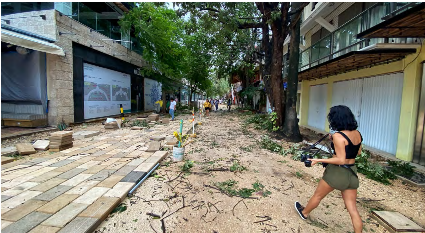
▲ Los trabajos de modernización de la Quinta Avenida están en la etapa final con la colocación de baldosas, aseguraron las autoridades municipales. Foto Juan Manuel Valdivia
